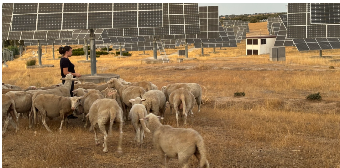
Rebaño en el parque solar Apolo II (Toledo)
