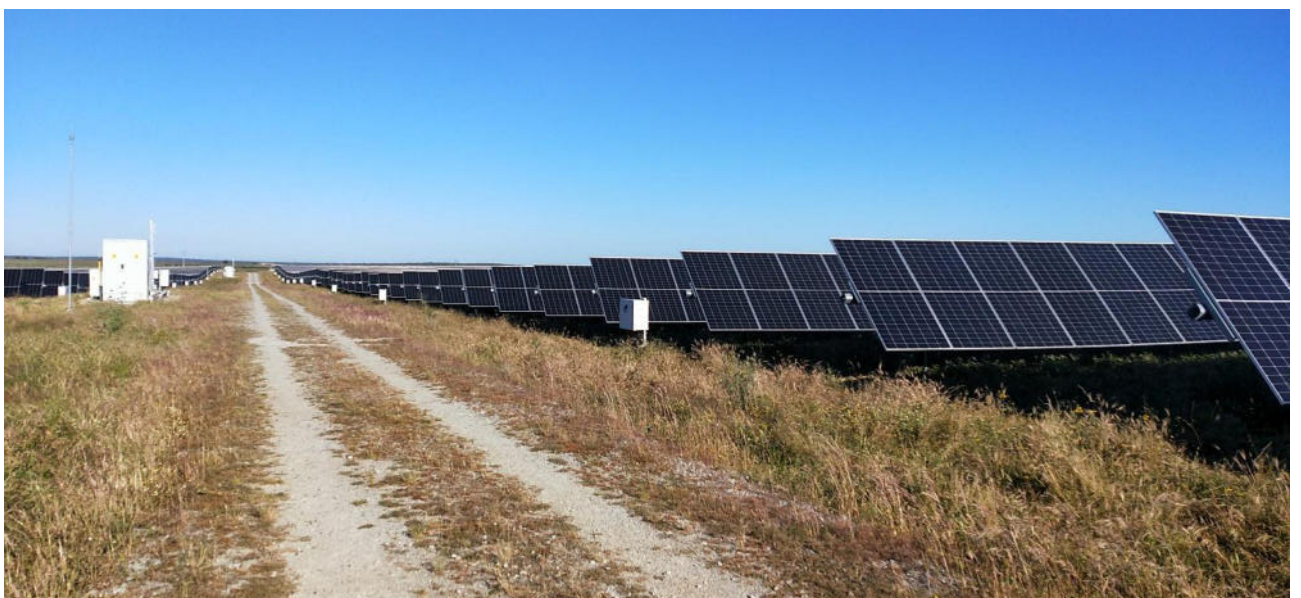
Tramo del transecto que discurre por el interior de la planta FV (mayo 2025).
