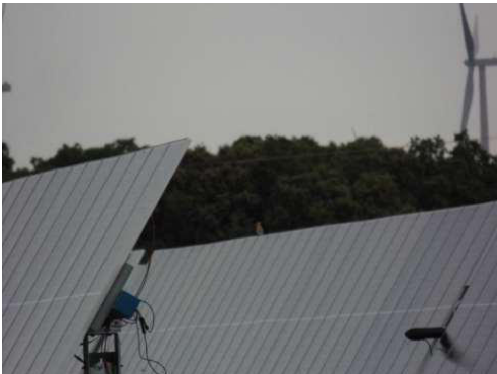
Abubilla ( Upupa epops ) posada en paneles de la planta FV en la visita del día 21/05/2025
