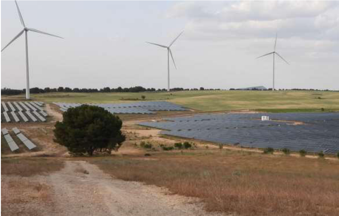
Vista general de la planta solar
