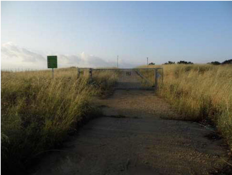
Vista de la entrada norte a la planta FV, lugar tomado como punto de observación nº 1 en la visita del día 25/06/2025
