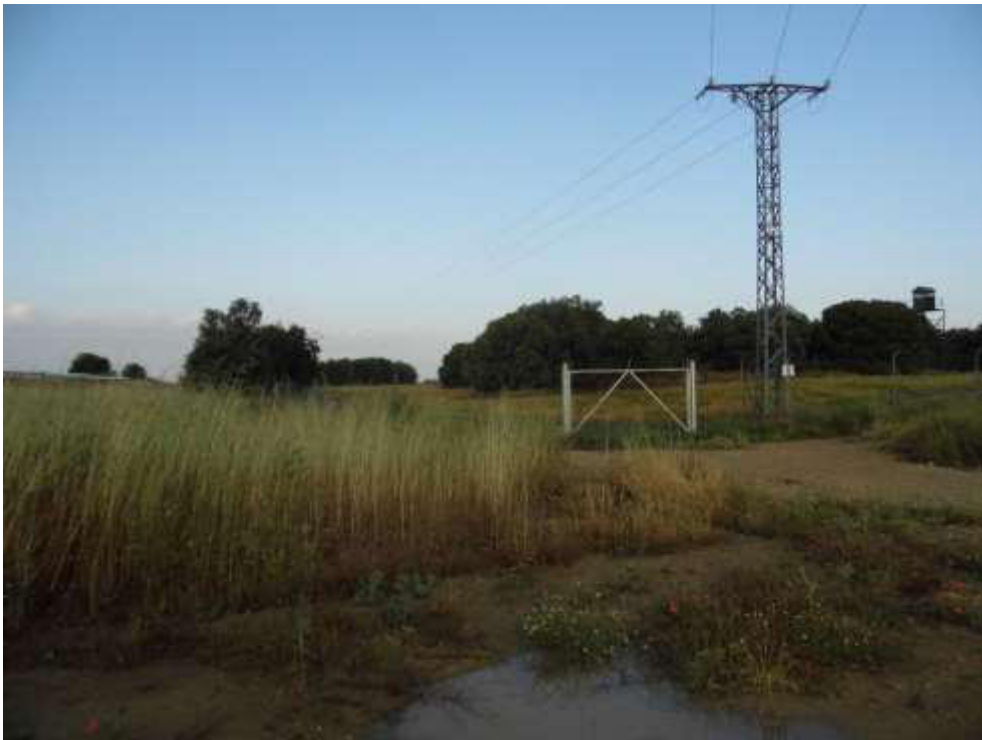
Vista del inicio del transecto exterior a la planta FV en la visita del día 25/06/2025
